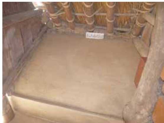
三和土改修後の状況
