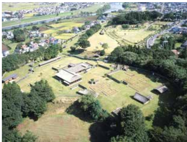
史跡根城の広場全景
