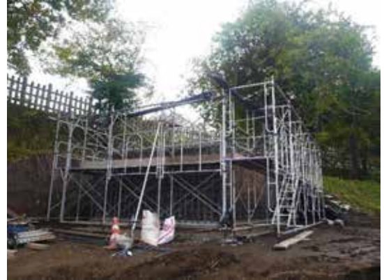
防火水槽工事状況
