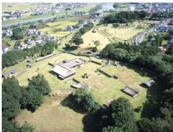
史跡根城の広場全景
